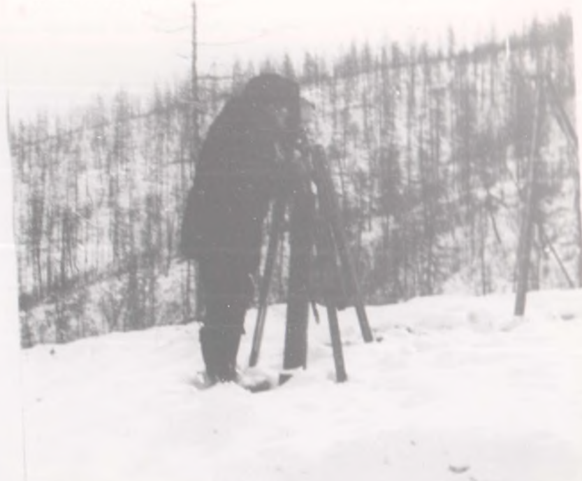
На строительстве дороги, 1980 год
