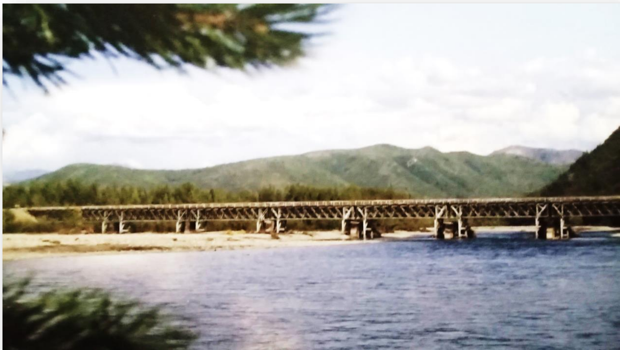
Мост р. Менкюле после реконструкции 2007г. Фундамент «быки»- водорезы прежние 1953 года.
